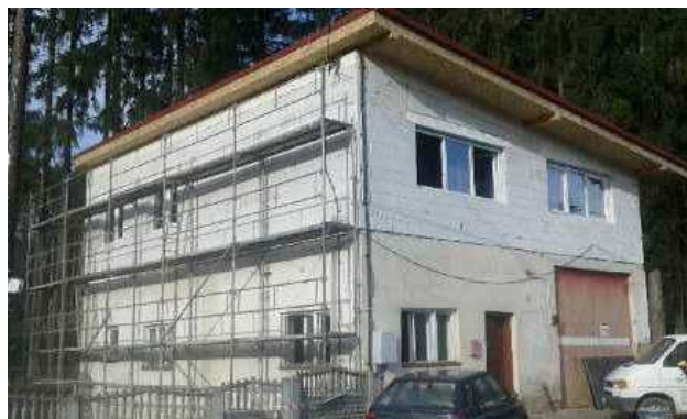
HZ počas rekonštrukcie
