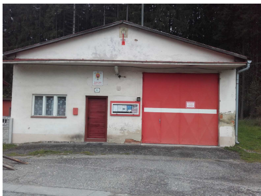
HZ pred rekonštrukciou
